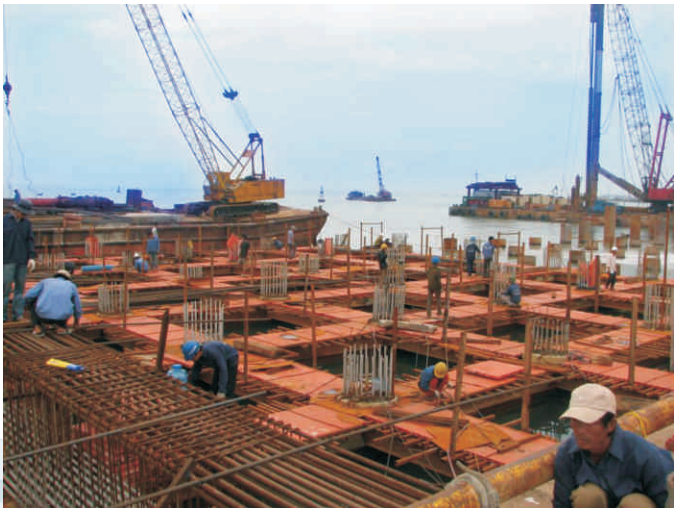
Thi công bến số 1 Cảng Dung Quất
